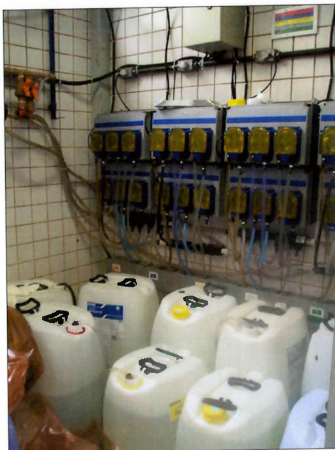
Figura 11. Sistema de dosagem automática de produtos químicos
